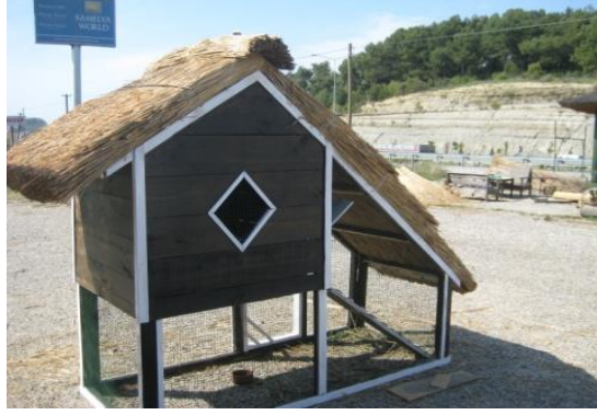
Fotoğraf: 6-7-8: Çatı ve terasta pres kamaş kaplama “yedirme kamaş”, şemsiye ve çatı uygulaması 1 .
