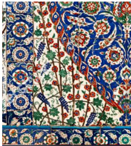
Foto 15. Sultanahmet Camii Kuzey Cephe Beden Duvarı Çini Pano
